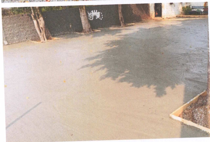
Obra de execução de piso de concreto
