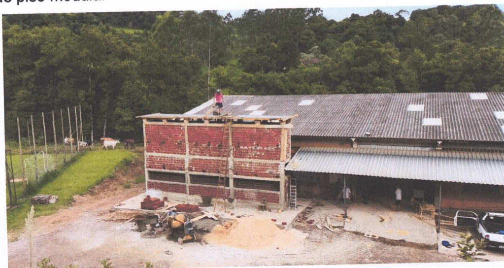
Obra em São Carlos SC, construção de churrasqueira na comunidade.
